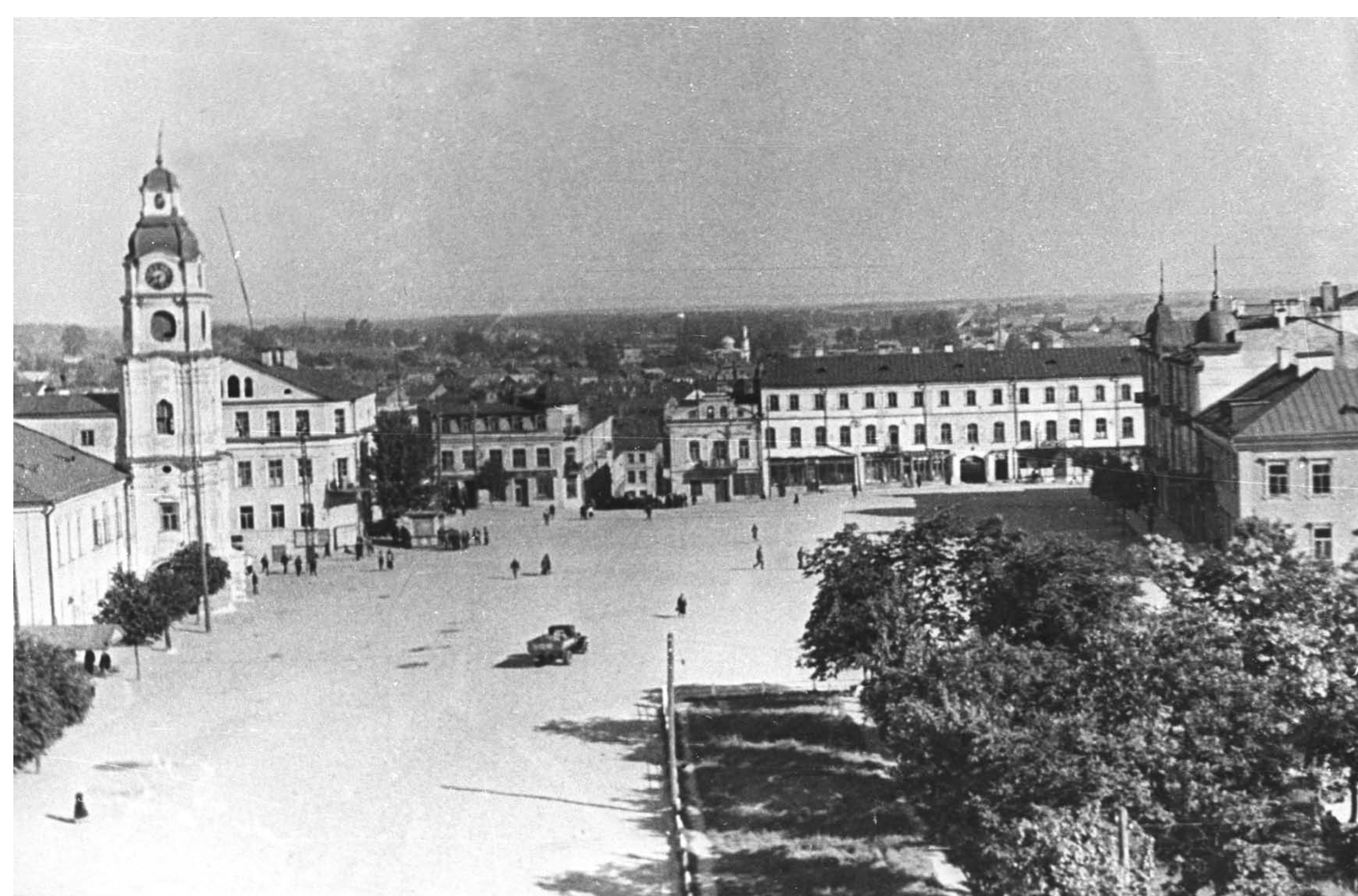
Freedom Square general view. 1940. [BSAF] Агульны выгляд плошчы Свабоды. 1940 г. [БДАКФФД]
